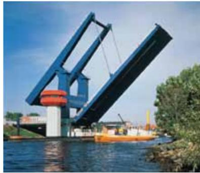
橋桁に使用されている高耐候性防錆塗料
